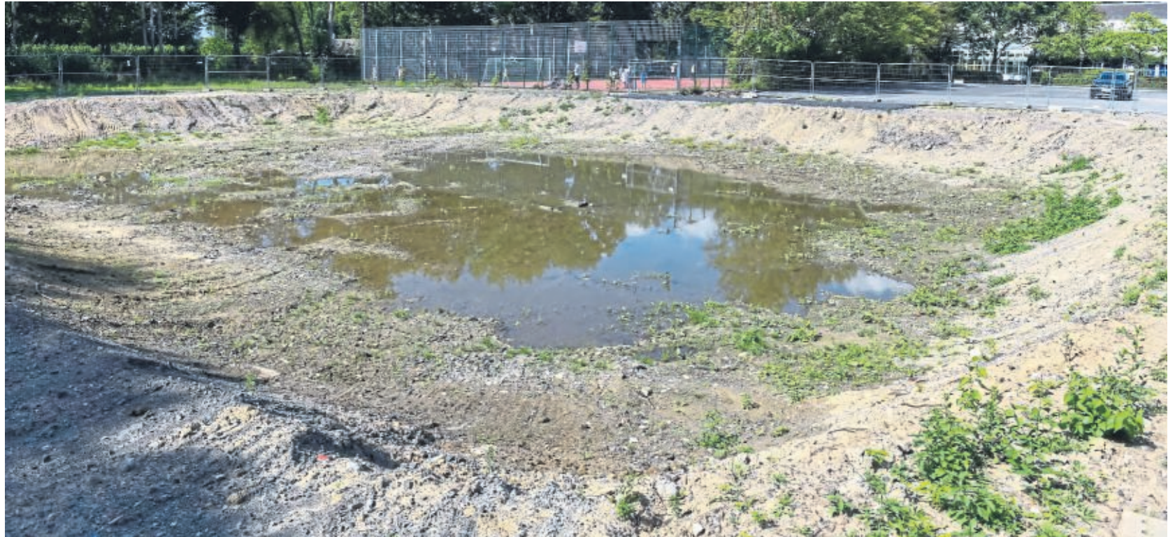
Die Baugrube der abgebrannten Zweifachhalle in Werl. Hier soll 2022 eine neue Halle gebaut werden.
